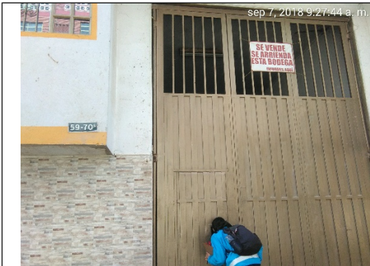
Foto No. 1 Fachada del establecimiento
